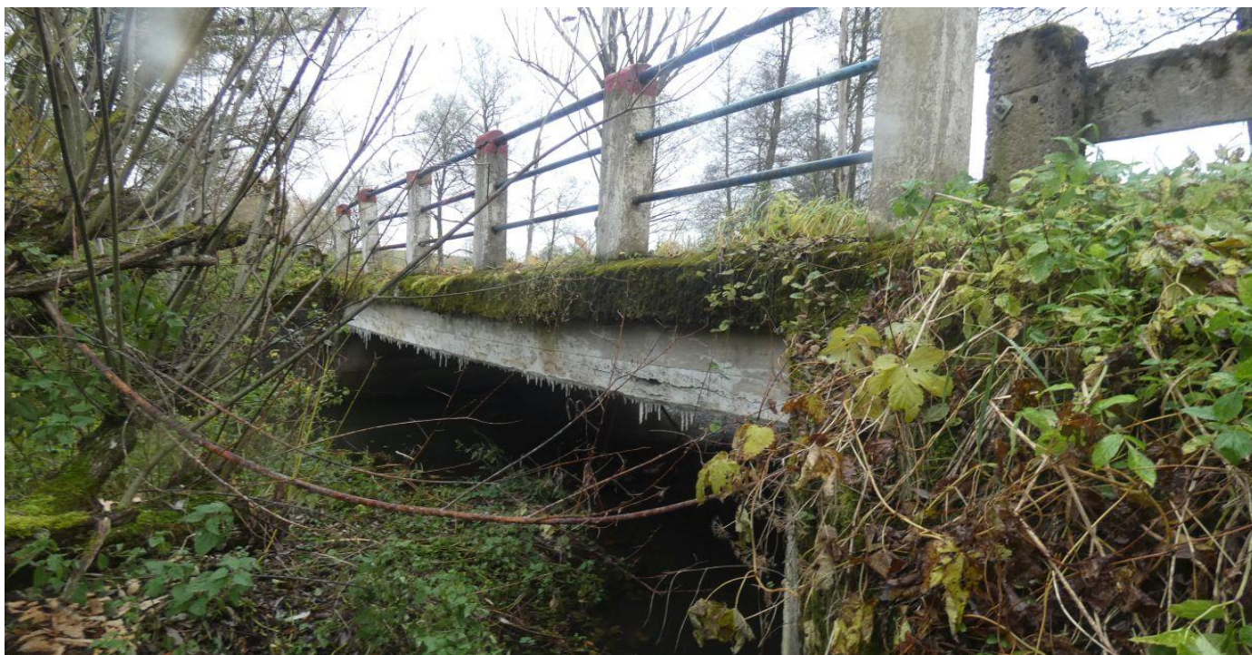
Fot. 3 Widok mostu z boku
