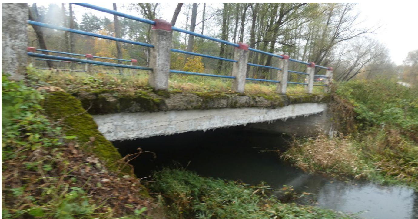
Fot. 4 Widok mostu z boku
