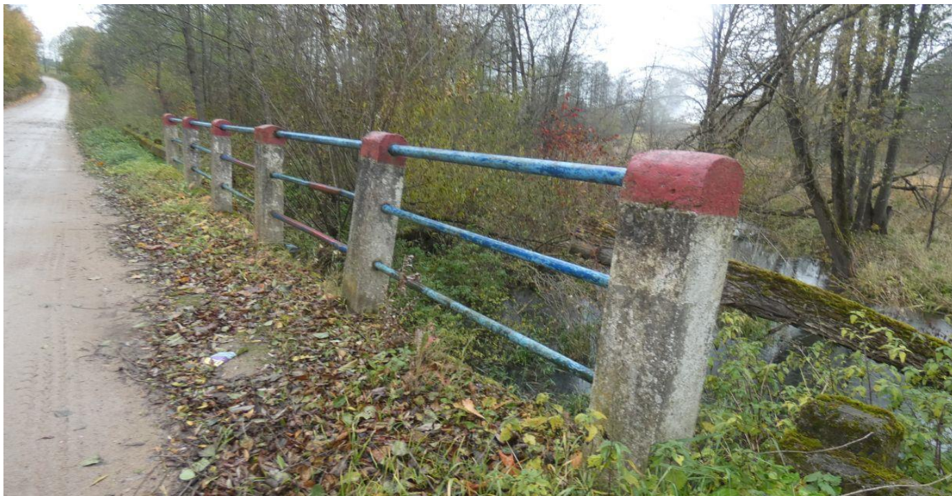
Fot. 9 Widok balustrad mostu
