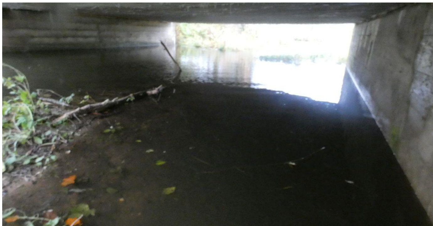
Fot. 6 Widok przestrzeni podmostowej
