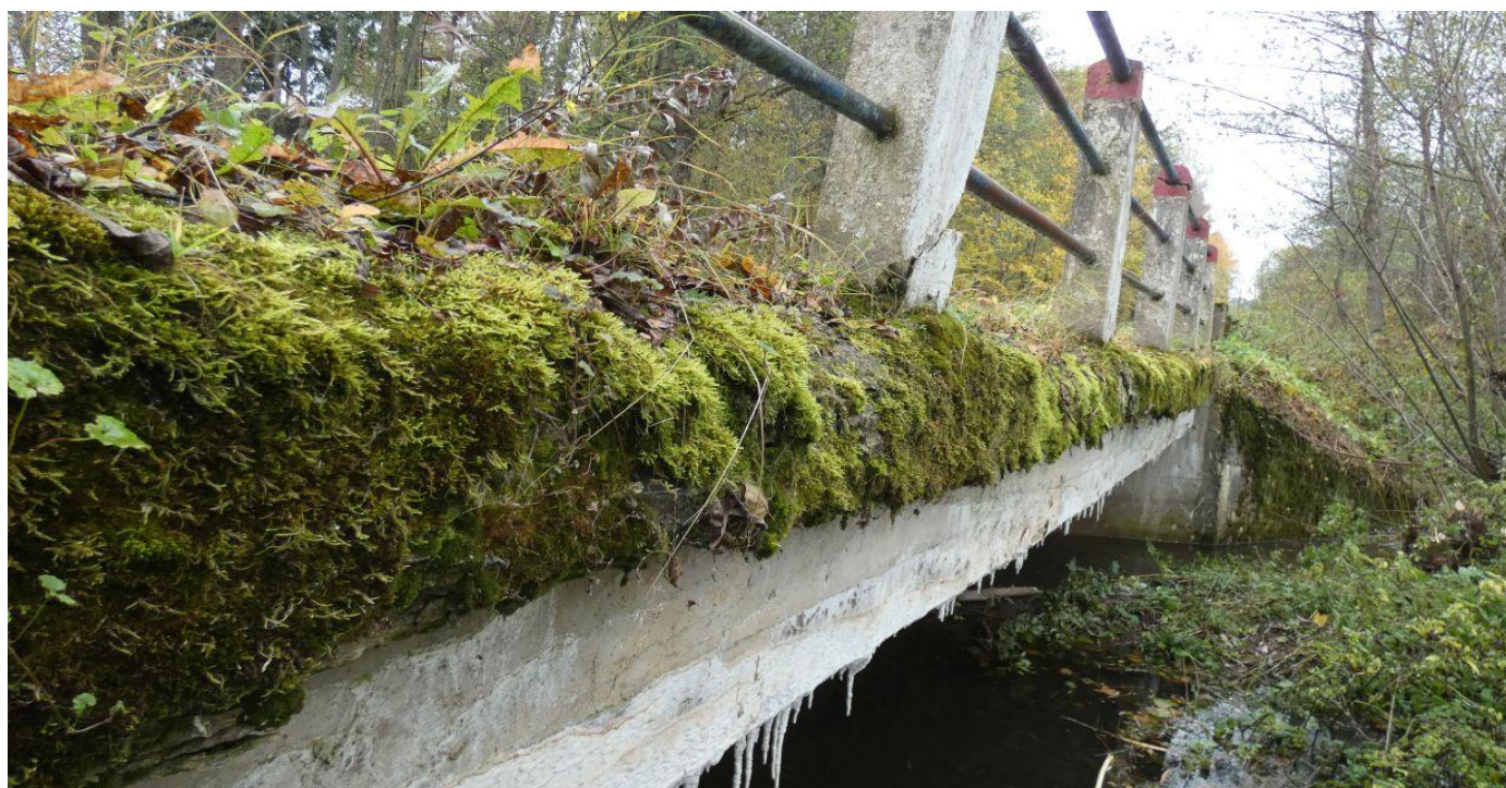
Fot.10 Widok belki podporęczowej, gzymsu mostu
